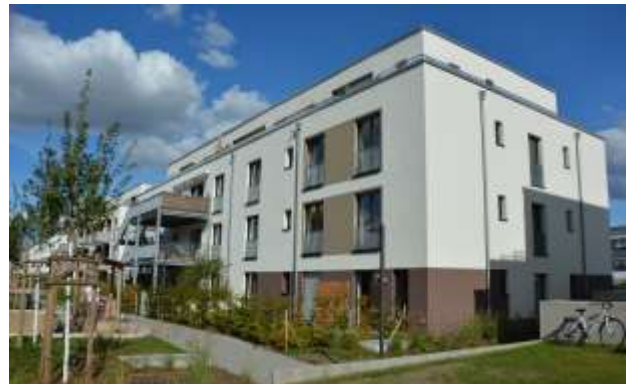
Das inklusive Haus - Gartenansicht. Die Terrasse ist zweiter Fluchtweg und verbindet die Etagen
